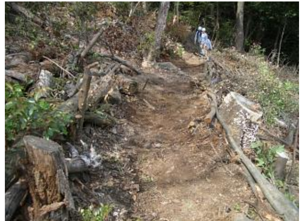
延長された作業歩道
